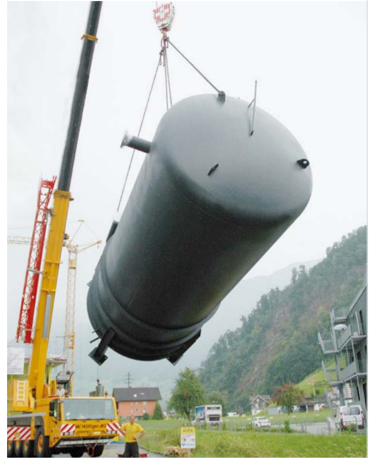
Der 100-Tonnen-Pneukran hebt den 50 000 Liter Speicher an.
