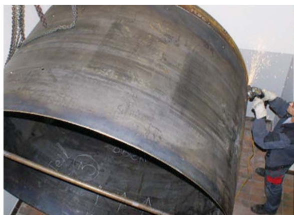
Der Speicher wird vor Ort zusammengesweisst.
