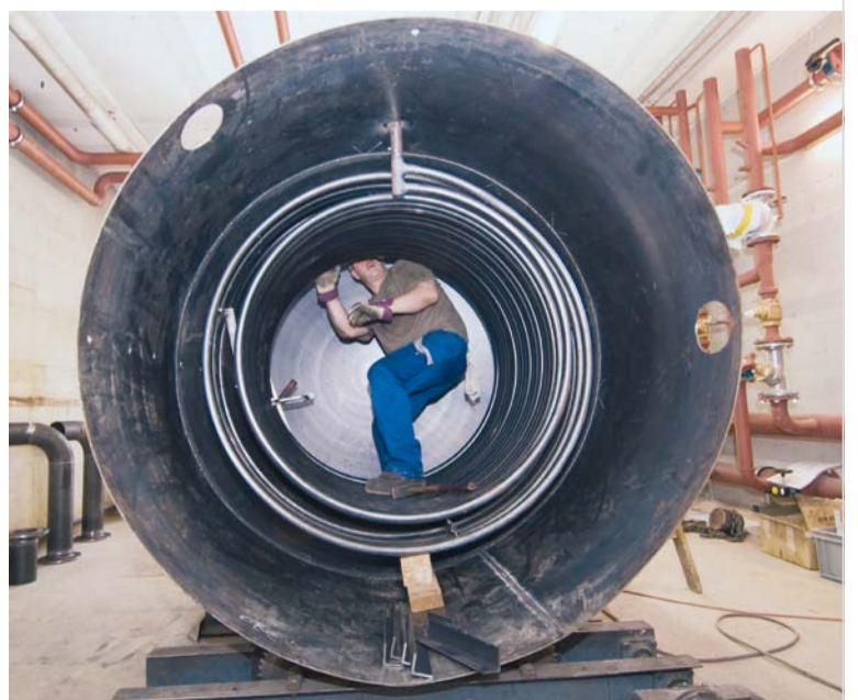
Die Speicher-Technik wird eingebaut.
