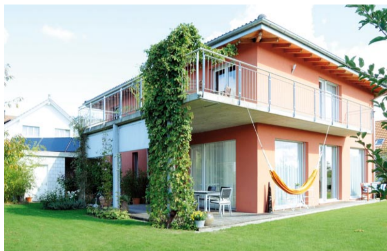
Einfamilienhaus in Liebistorf bei Fribourg.
