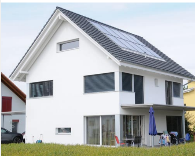
Neubau in Lyssach bei Bern.
