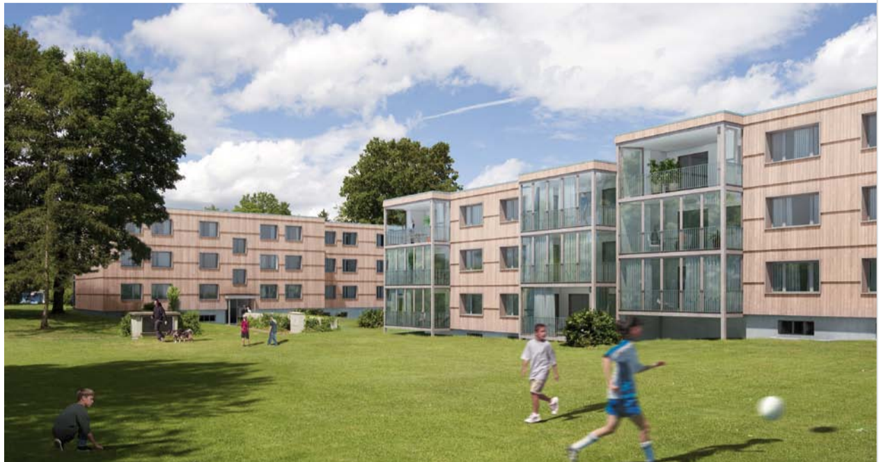
Sanierungsprojekt im Quartier „Im Langacher“ in Greifensee ZH.
