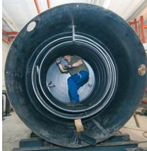
Platzmontage: So kann auch am ungünstigsten Ort der beste Speicher eingebaut werden – nach Mass.
