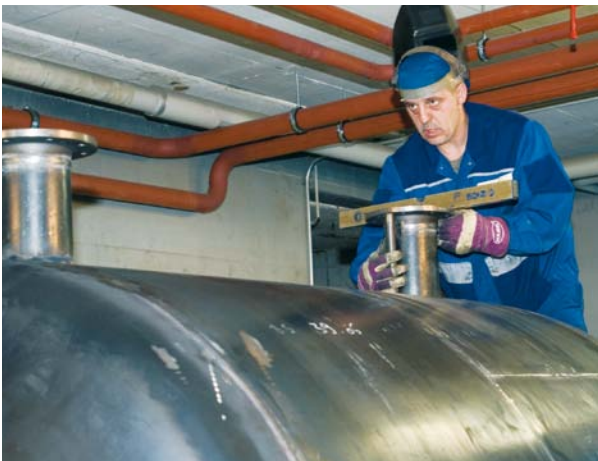
...der obere Boden und die Anschlüsse geschweisst.
