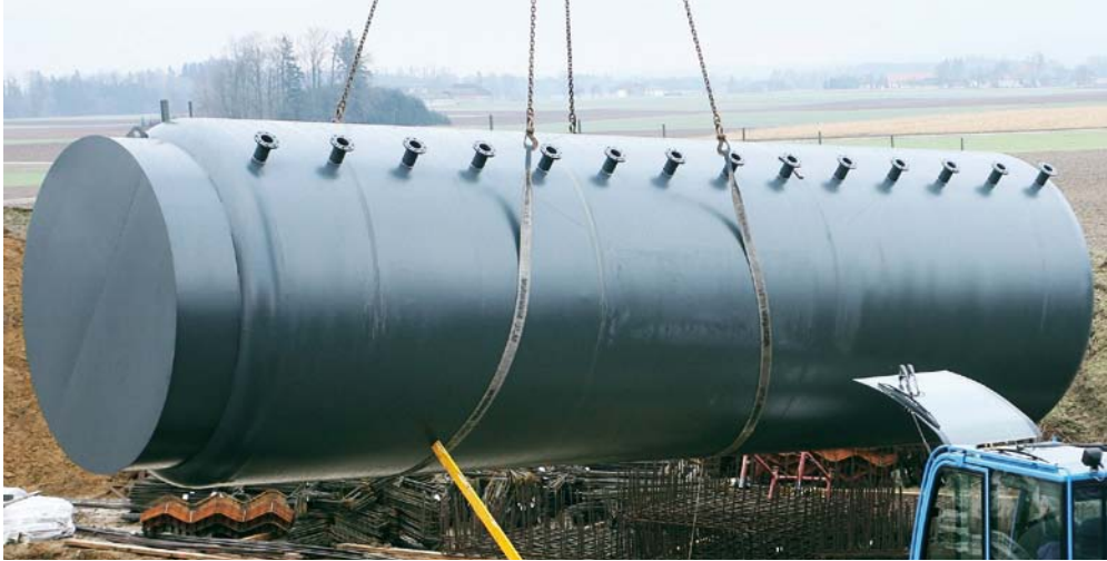
Solarspeicher: 85'000 Liter, 11,5 Meter lang und sieben Tonnen schwer.
