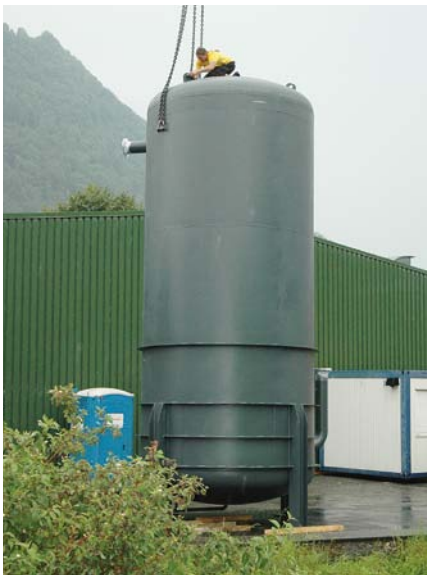
Energiespeicher: 50'000 Liter, 8 Meter lang und 6.5 Tonnen schwer.
