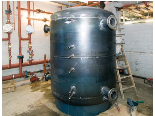
Der fertige Speicher nach der Aufrichtung.
