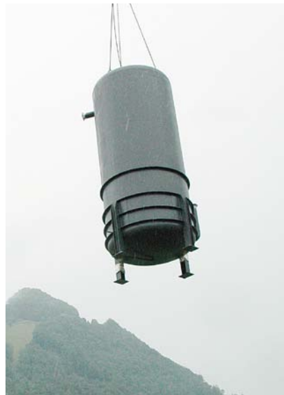
Energiespeicher: 50'000 Liter, 8 Meter lang und 6.5 Tonnen schwer.
